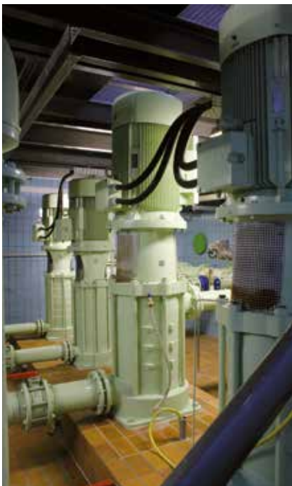
Die Reduzierung der Drehzahl um 20 % kann bei Pumpenanwendungen im Idealfall die Energiekosten um bis zu 50 % senken
