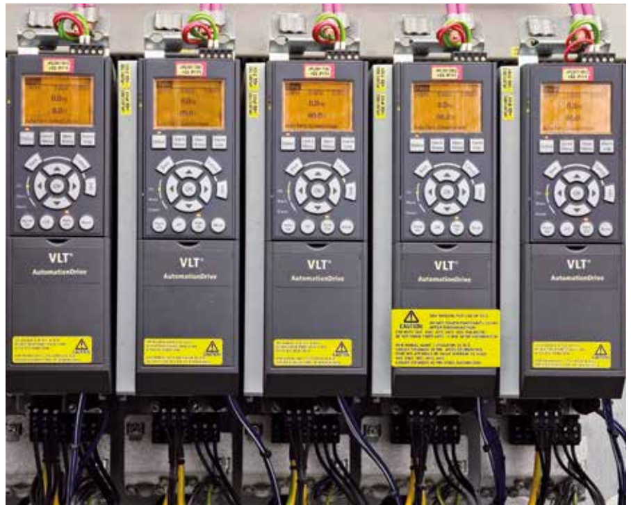
Der Einsatz von Frequenzumrichtern ist heute Stand der Technik und findet immer mehr Verbreitung. Von den ca. 75 Millionen in Europa installierten Motoren wird bereits ca. jeder Achte drehzahlregelt.
