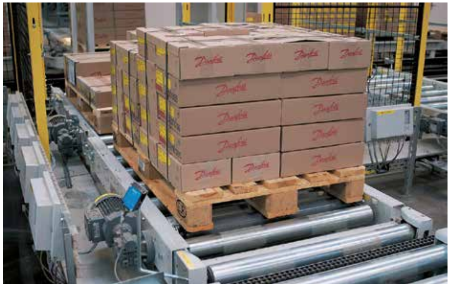
Für die Drehzahlregelung von Fördersystemen kommen heute bereits vielfach Frequenzumrichter zum Einsatz. Diese optimieren den Energieverbrauch, abhängig von der zu transportierenden Last sowie der benötigten Drehzahl.
