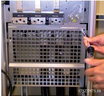
Abbildung 3.50: Montage der EMV-Abschirmung.
