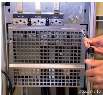
Abbildung 5.36: Montage der EMV-Abschirmung.
