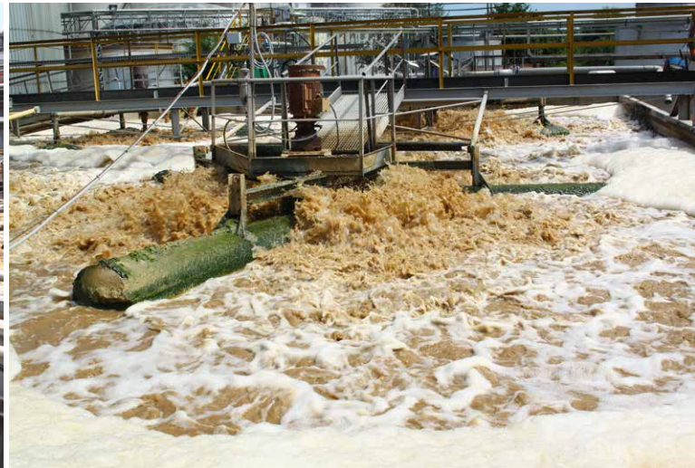
Faenza Depurazioni srl – Klärbecken mit Sauerstoffanreicherung und aerobischer Belebung
